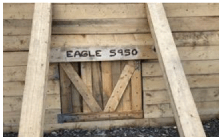
Foto 12 - Endgültig installierte Tür auf Level 5950 Davis Keys
