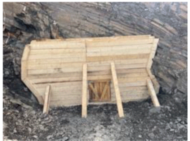
Foto 10 - Holzbalken, die das Dach tragen / Rückseite des Stolleneingangs und Foto 11 - Abschluss mit Holz
